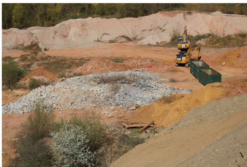
Zerkleinerte Fundamente liegen zum Abtransport
